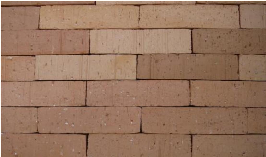
**Figura 26** – Tijolo cerâmico estrutural maciço 4,5x10x19cm
