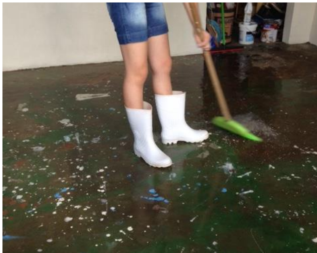
Foto 6: Passando o ácido para remoção de impurezas e tintas indesejadas.
