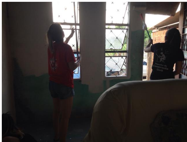
Foto 1: Pintura das paredes com a tinta na cor palha utilizando rolo de lã.
