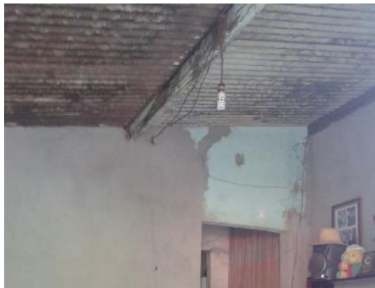
Foto 8: teto da sala de televisão antes da reforma. Fonte: tirada pelas autoras
