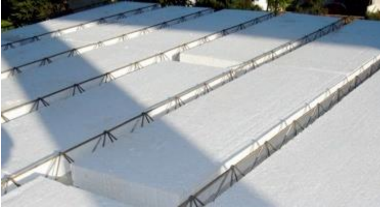
Figura 12- Forro com placas de isopor e trilhos treliçados. Fonte: http://www.homekit.com.br/projeto_de_estrutura.htm
