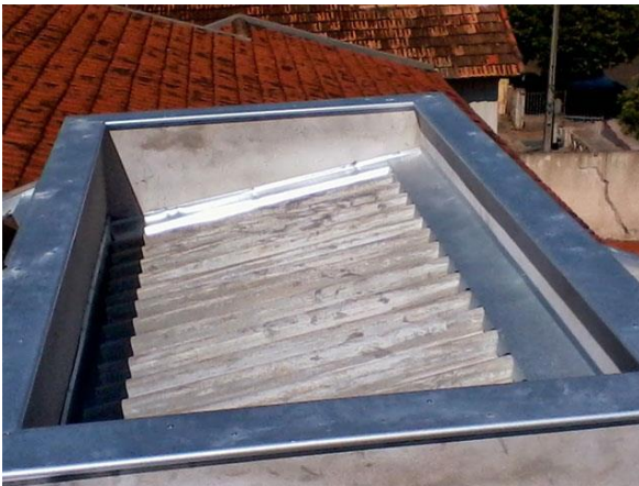
Figura 16 – Cobertura com calhas e rufos. Fonte: http://www.calhasnovalondrina.com.br/
