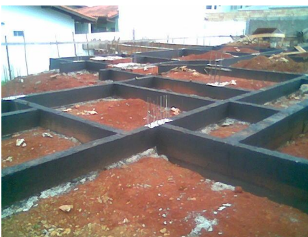
Figura 07- Fundação já impermeabilizada.
