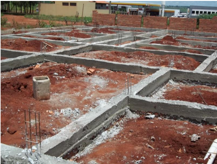
Figura 06- viga baldrame já concretada.
