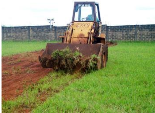
Figura 01- máquina realizando limpeza e nivelamento do terreno. Fonte: http://www.servlimpcr.com.br
