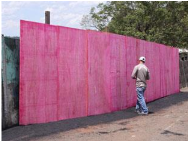
Figura 04 – tapume fechando a obra.
