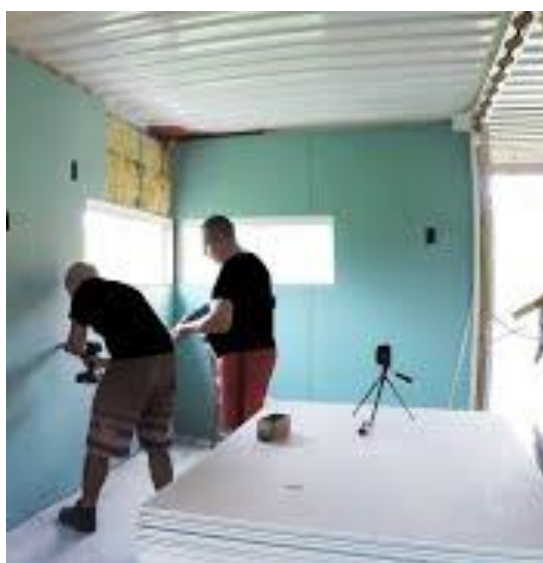
Figura 34: “Instalação de Drywall nas paredes de um container”
