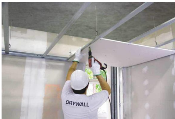
Figura 51: “Aplicação de forro em placas de gesso acartonado (Drywall)”
