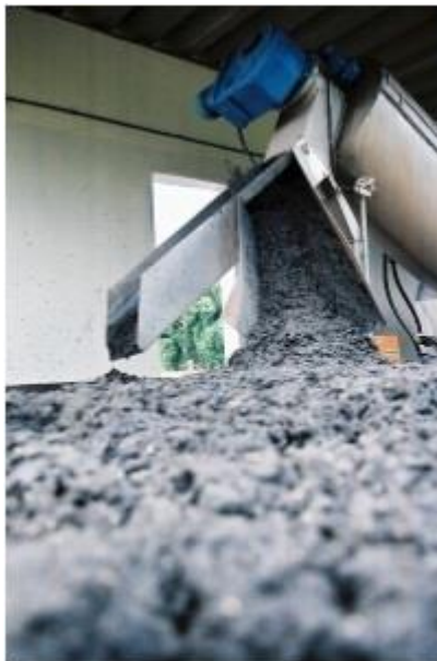
Figura 34 - Sistema de desidratação de lodos
