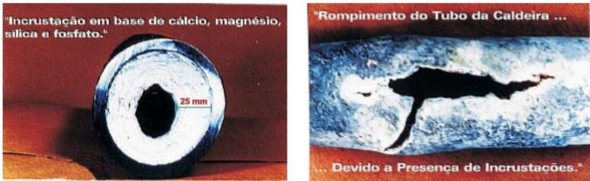
Figura 15 - Incrustações e rompimento de tubo de caldeira
