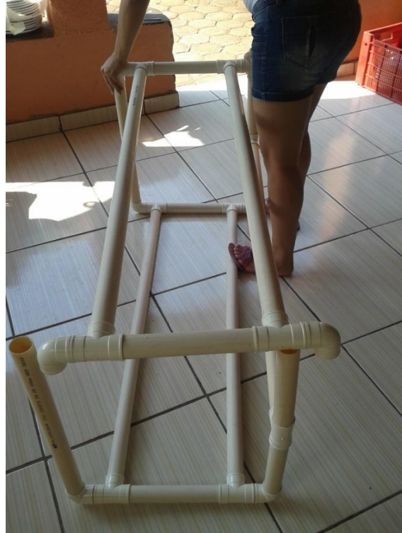
Montagem da parte superior da mesa.
