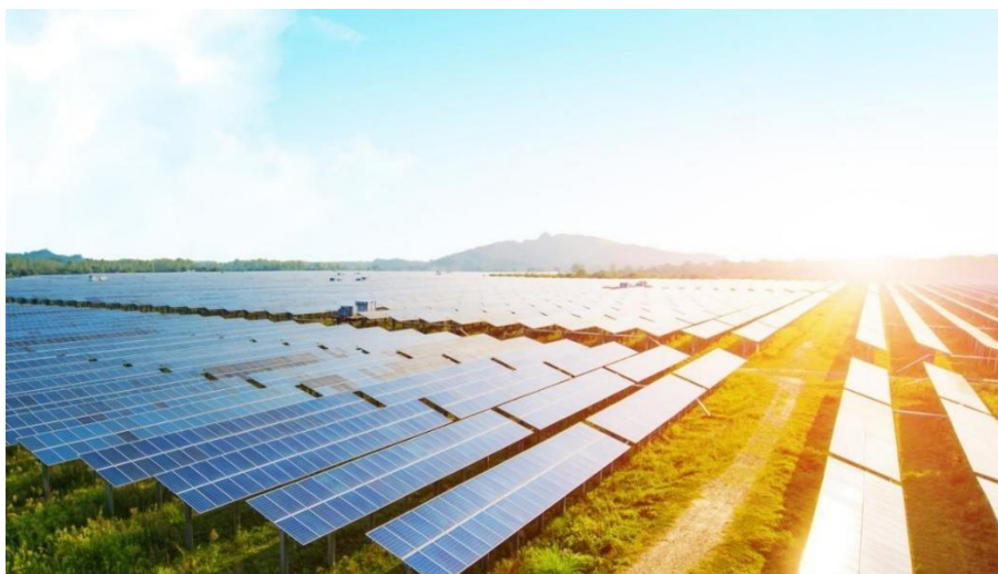
Figura 35 - Usina Fotovoltaica Pereira Barreto Fonte: Megawhat energy, 2021
