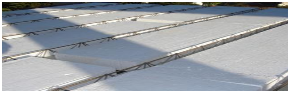
figura 10- Laje de EPS
