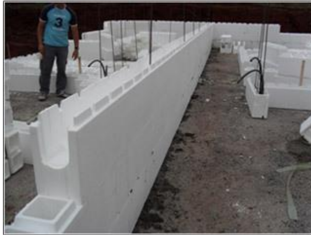
Figura 4-início das paredes
