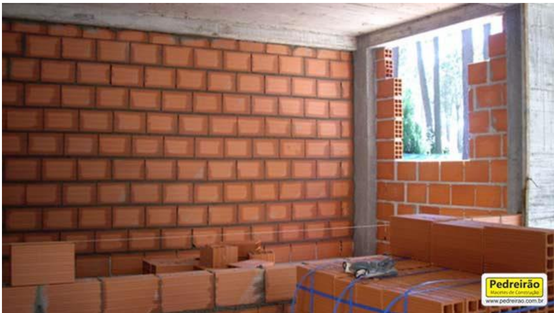
figura 8-parede convencional (bloco cerâmico)
