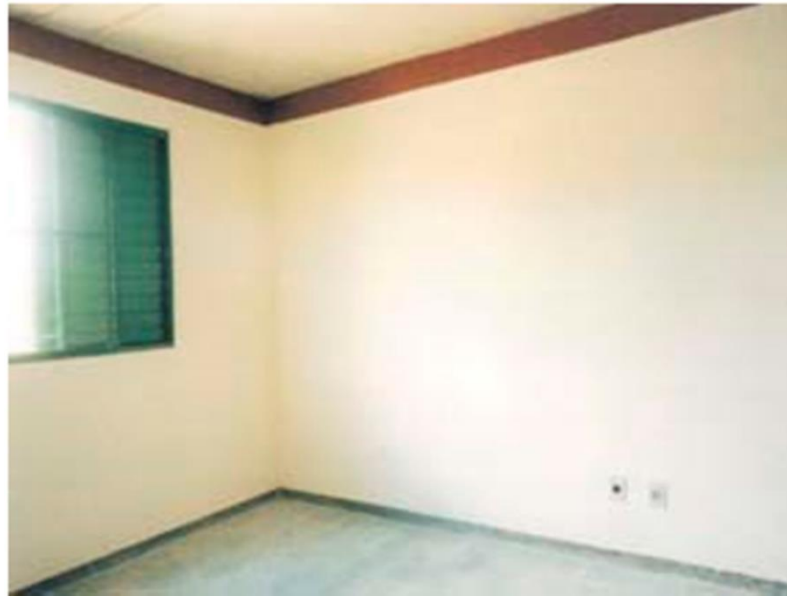
Figura 14: Parede acabada, revestida com massa corrida e látex branco.
