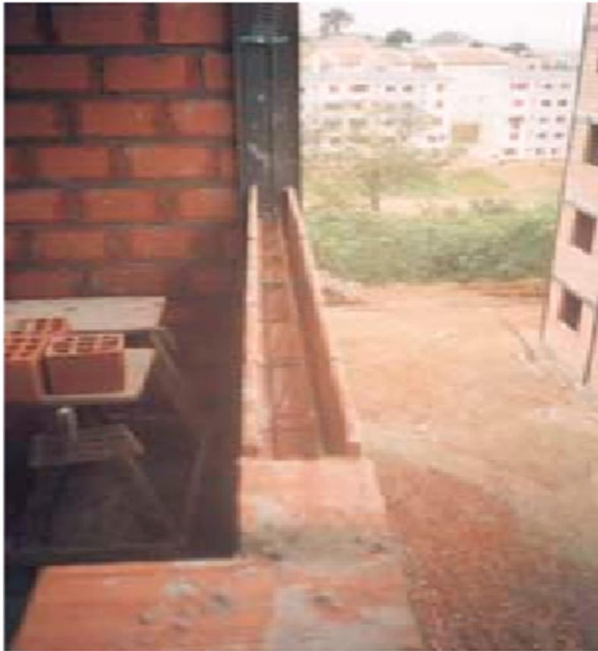
Figura 11: Detalhe de verga das janelas
