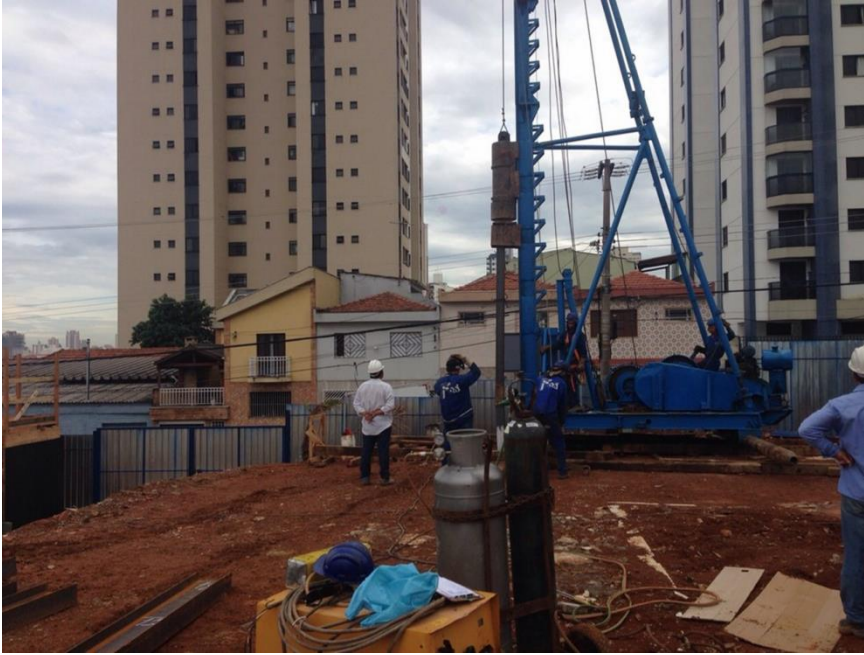
Figura 8: A realização da fundação de uma residência com a utilização de perfis metálicos e sendo inseridos pelo uso de “bate-estaca”.
