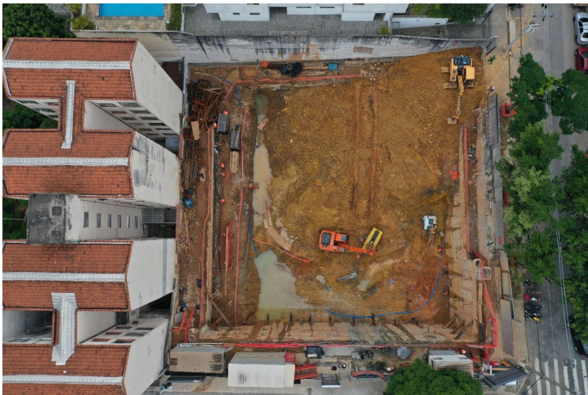
Figura 1 - Vista panorâmica - Obra Valente.
