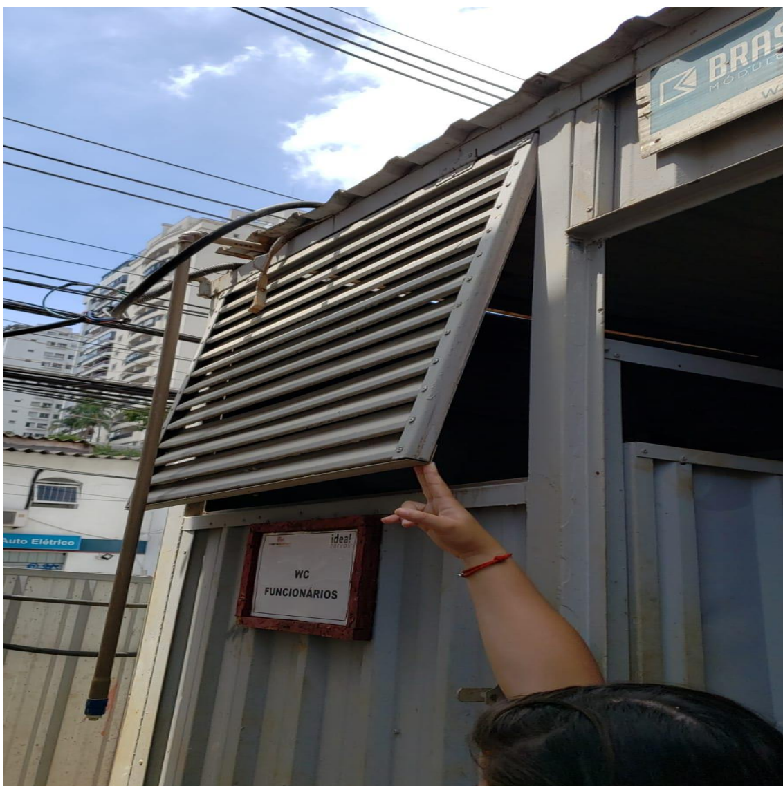
Figura 12 - Ventilação quebrada.
