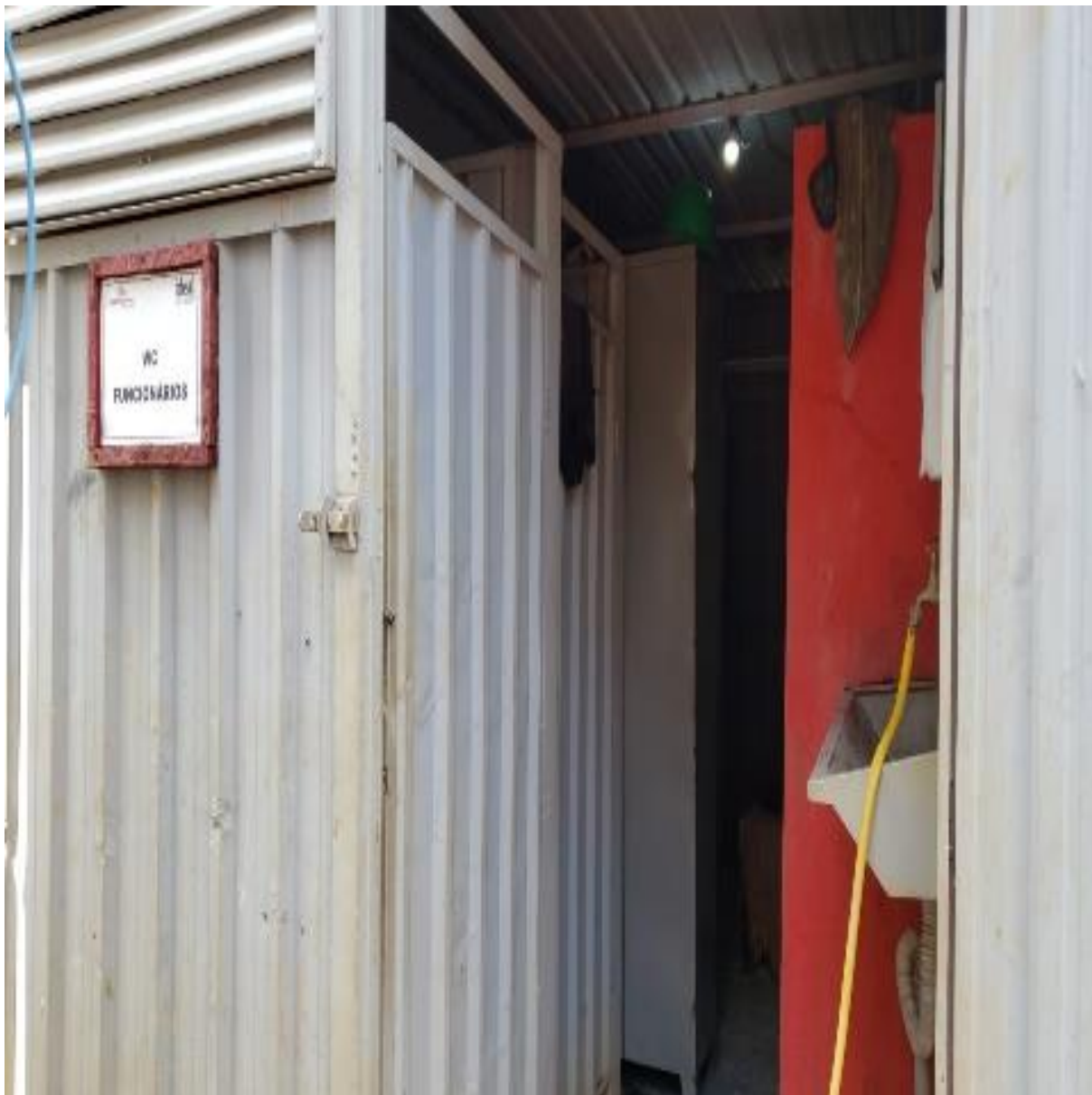
Figura 3 - Instalações sanitárias irregulares.
