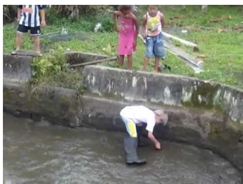
Figura 1: Limpeza de tanque
