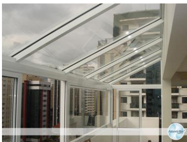
Figura 28: Cobertura de vidro temperado com ferragens em alumínio
