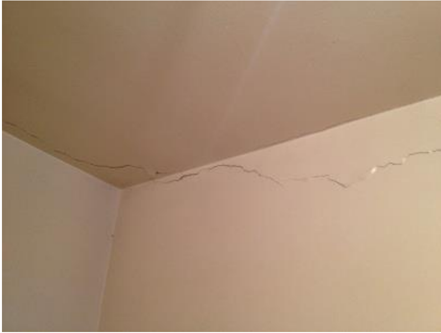
Figura 12. Trincas em alvenarias e vigas do prédio comercial.
