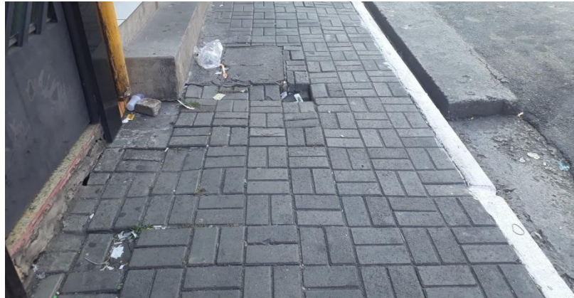
Figura 46: Detritos presente no Trecho 5: Rua Dr. Campos Moura.
