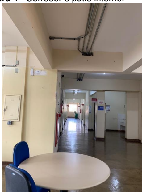
Figura 4 - Corredor e pátio interno.
