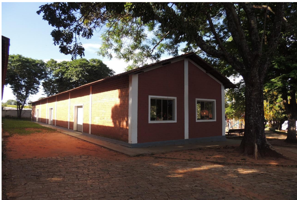
Imagem 1 - Vista externa do barracão
