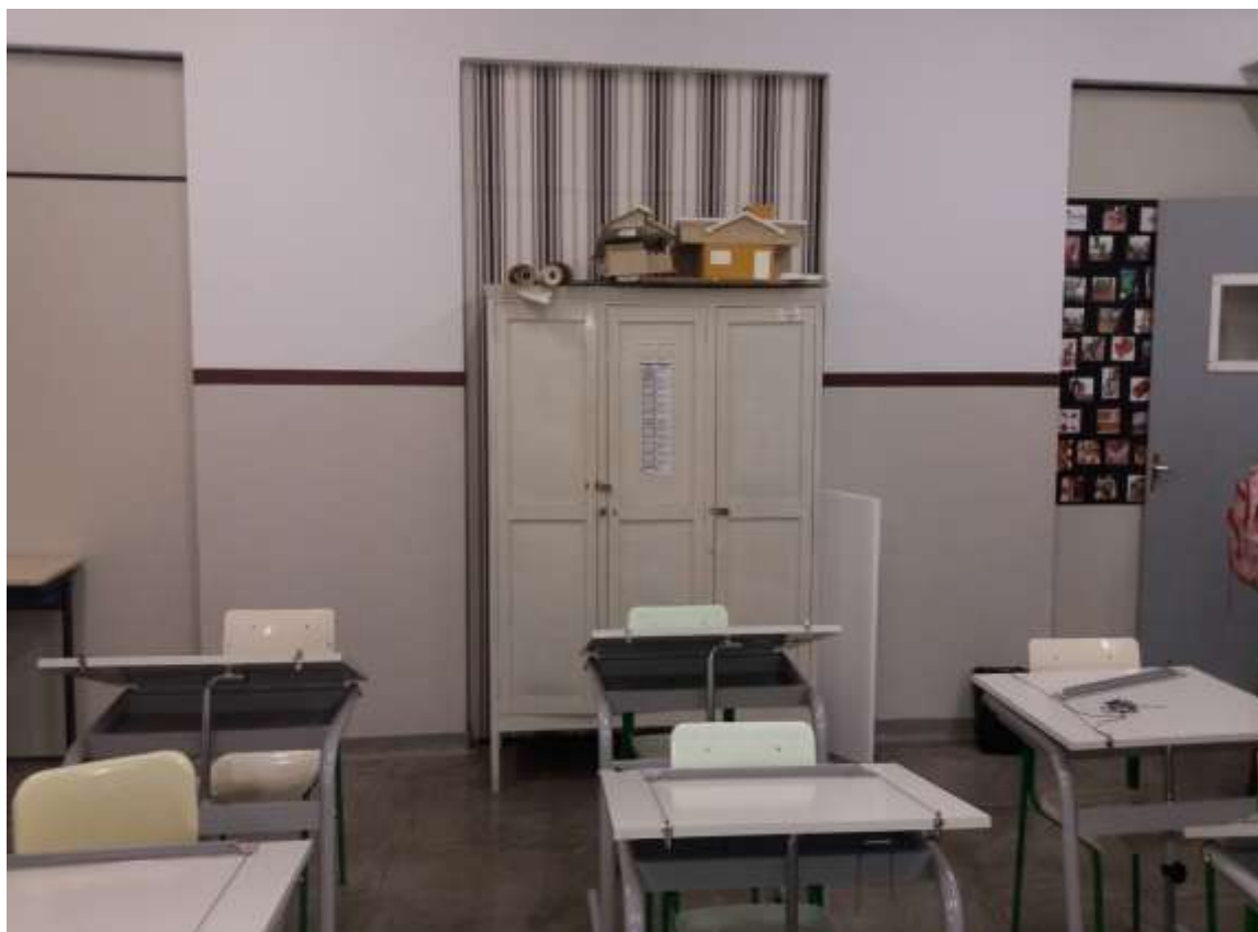
Figura 35 – Falta de Organização e restauração do Armário.
