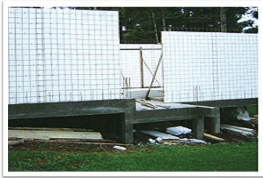
Figura 1- As paredes são construídas com painéis de poliestireno expandido de no mínimo 80 mm.
