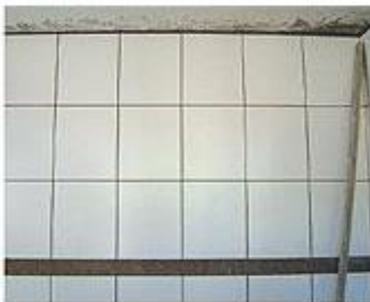
Figura 12- Parede após aplicação do revestimento
