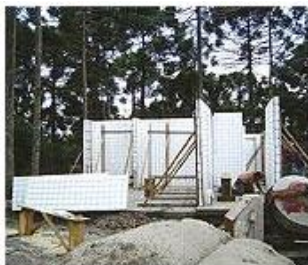
Figura 10 - Escoras reguláveis garantem a verticalidade dos painéis
