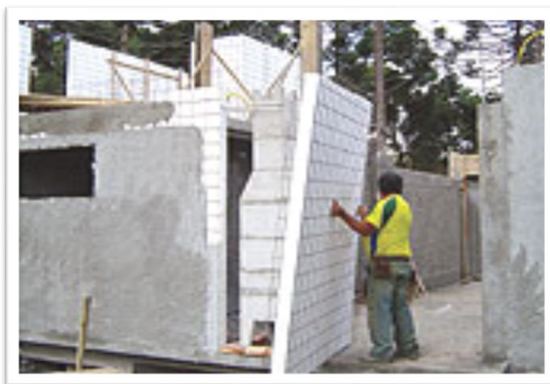
Figura 9 - Pedacos de tela devem ser colocados nos cantos dos painéis e das portas e janelas.
