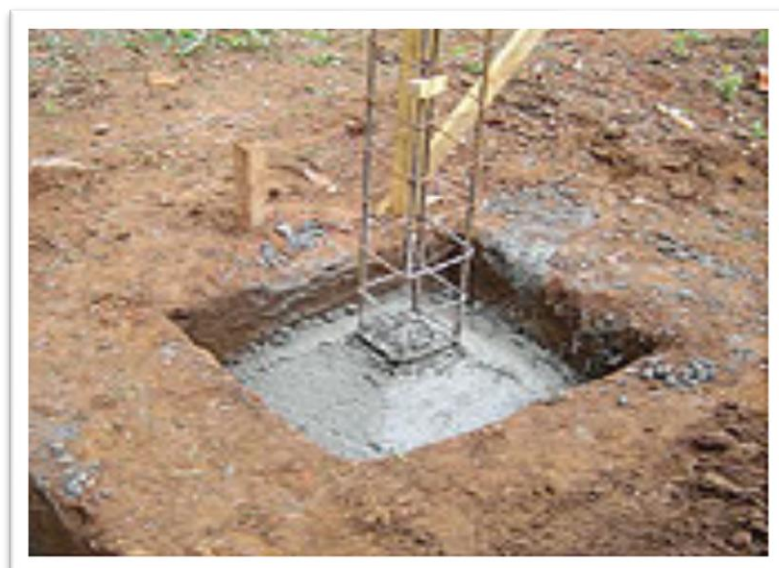
Figura 5 - A primeira etapa da execução é a preparação das fundações de acordo com o cálculo estrutural.
