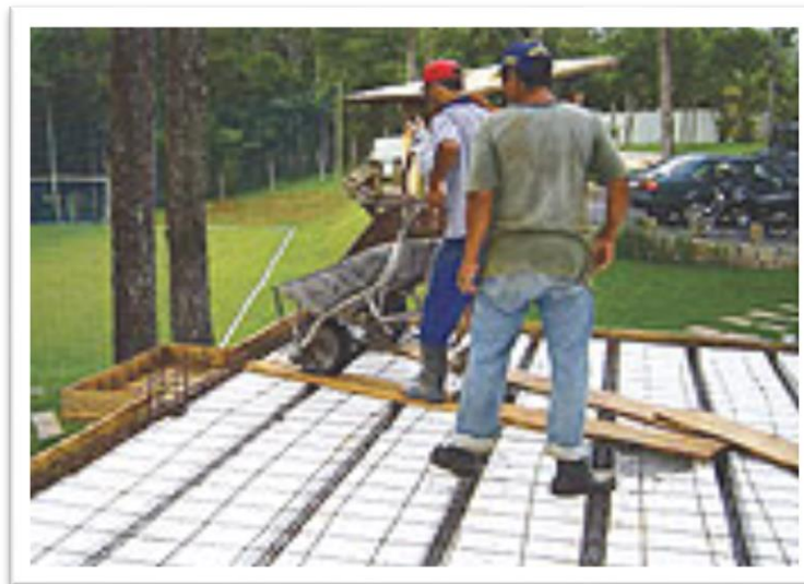
Figura 8 - Em pontos onde o vão é maior são utilizadas malhas de 3,4 mm de 15 cm x 15 cm.
