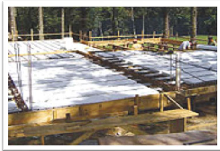
Figura 7 - Esse piso com laje treliçada unidirecional emprega painel de EPS de 10 cm.
