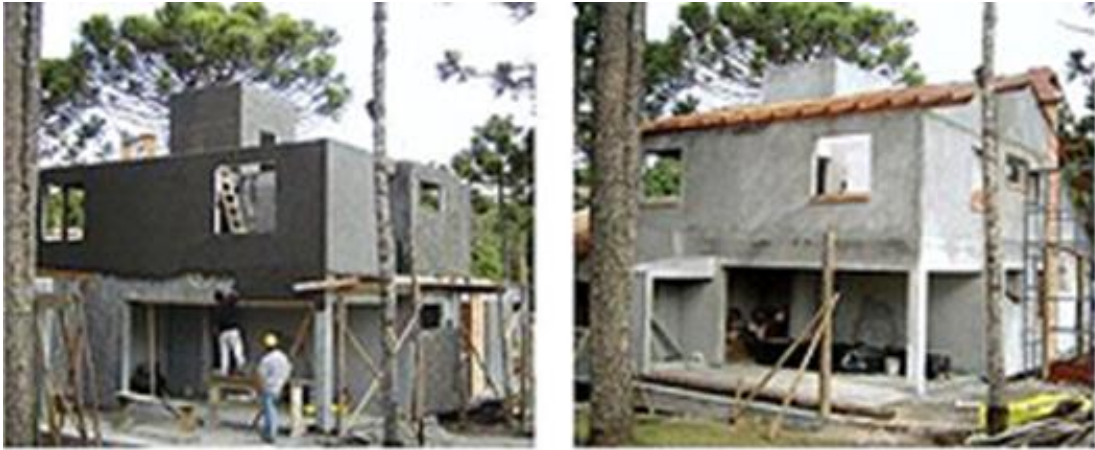
Figura 15 e 16 – A colocação de caixilhos e batentes é realizada apenas depois da cura total do revestimento.
