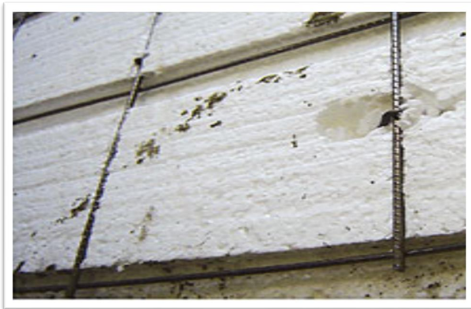
Figura 2 - Duas telas de aço eletrossoldadas, presas por grampos, unem as peças.
