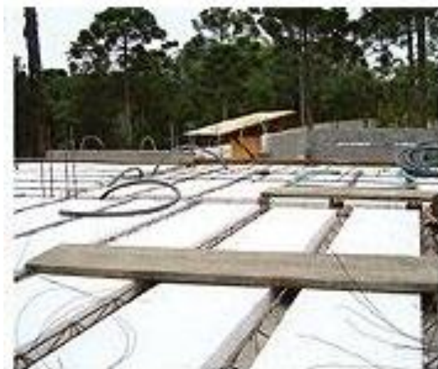
Figura 11 - Passagens para instalações elétricas e hidráulicas
