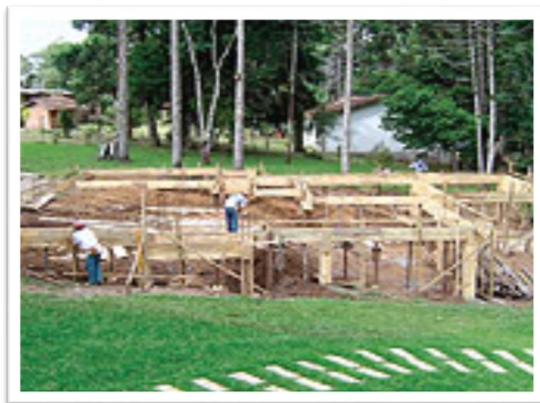
Figura 6 - Arranques de aço instalados 30 cm acima do piso permitem a fixação dos painéis.
