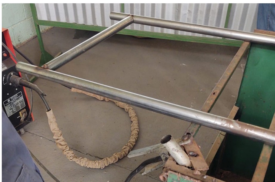
Figura 4 – Montagem inicial dos travamentos.
