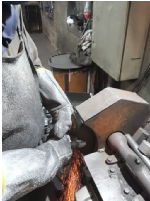
Figura 47 – Rebarbação com a policorte rebarbadora
