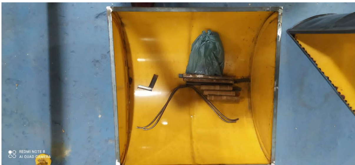
Figura 6 – Instalação das cantoneiras na parte inferior.
