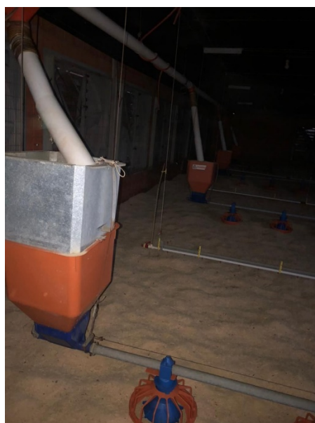
Figura 29: cooler instalados para transportar alimento ao comedouro Fonte: Ferracini, 2021
