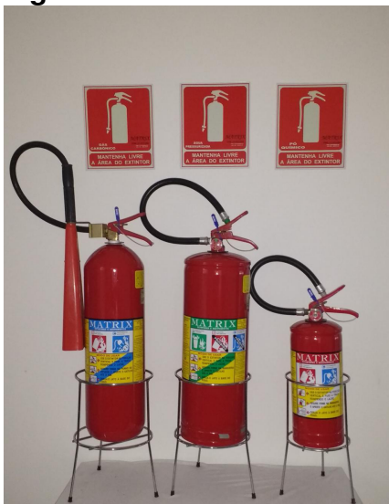
Figura 8 - Extintor de incêndio
