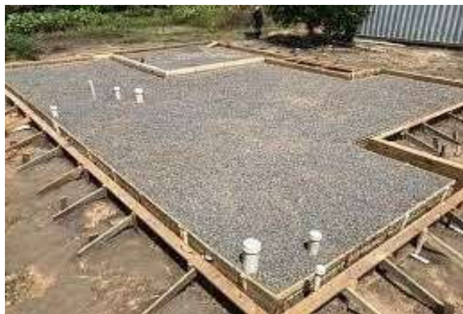
Figura 21- Exemplo da colocação da malha e tubulações elétricas.
