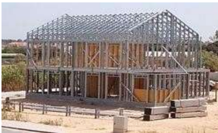
LSF (light steel frame): construção em aço leve
