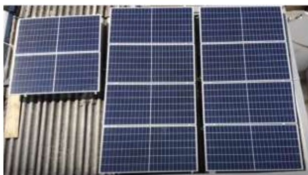
Figura 15- Exemplo de instalação de placas
