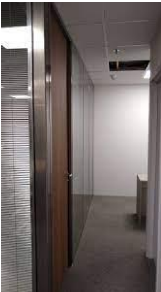
Figura 7 - Obra com acabamento da estrutura diferenciada em aço inox
