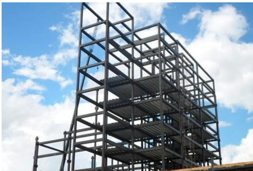
Figura 3 - Estrutura em aço
