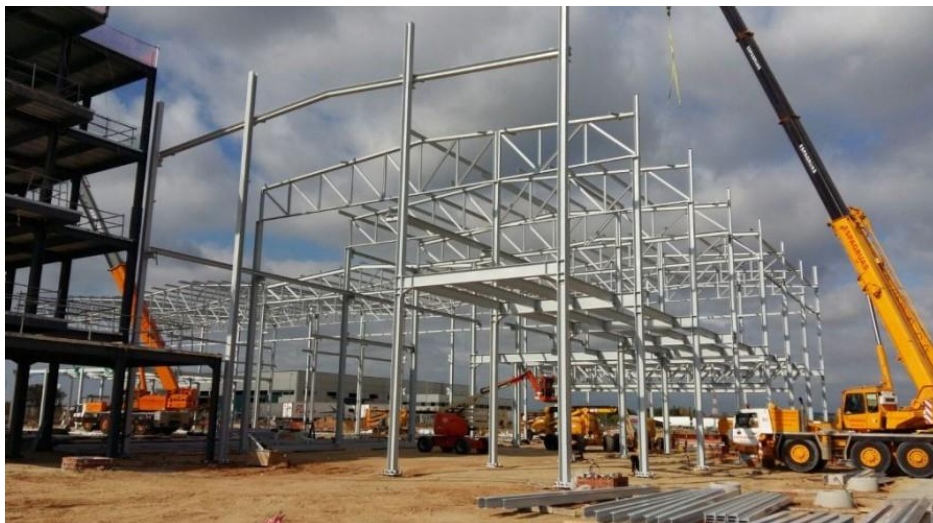
Figura 8 - Obra com estruturas de aço
