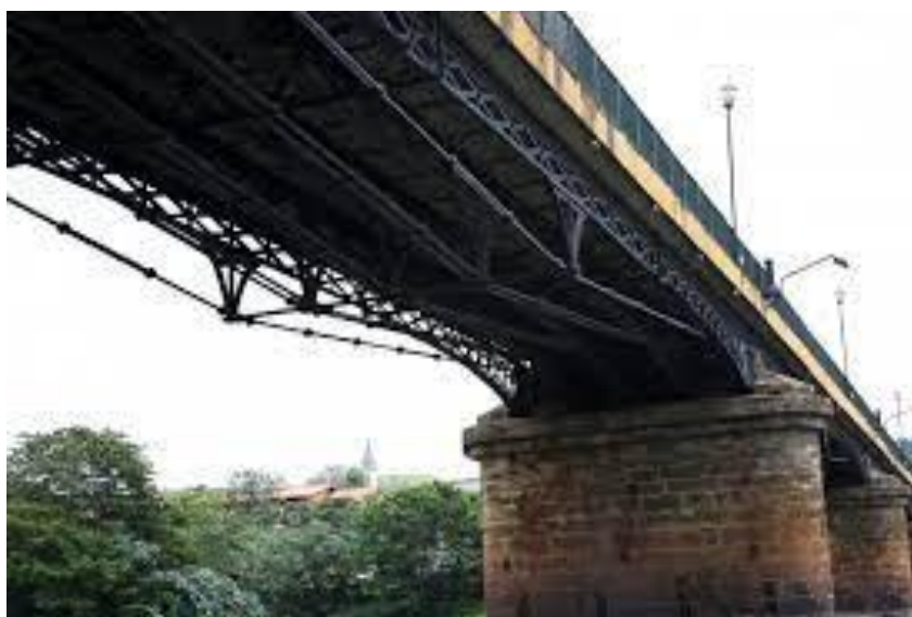
Figura 2 - Ponte da Paraíba do Sul (Rio de Janeiro, Brasil)
