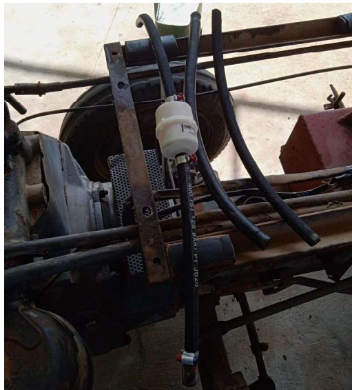
Figura 5 – Mangueiras e Filtro Novos.
