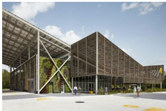
b) Estrutura vista de fora
