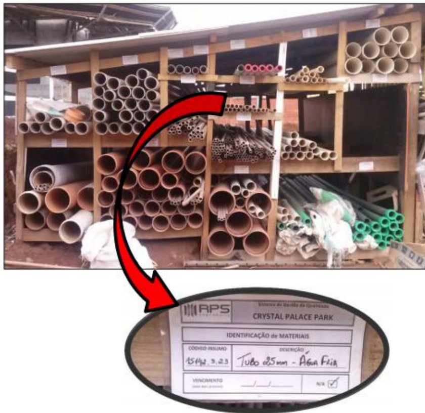
Figura 12 – Etiqueta de identificação utilizadas no armazenamento de tubos
