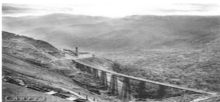
Figura 1: Construção da ferrovia pioneira paulista: São Paulo Railway.
