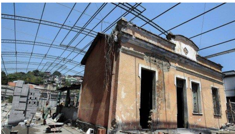
Figura 29: TENSF em fase de demolição
