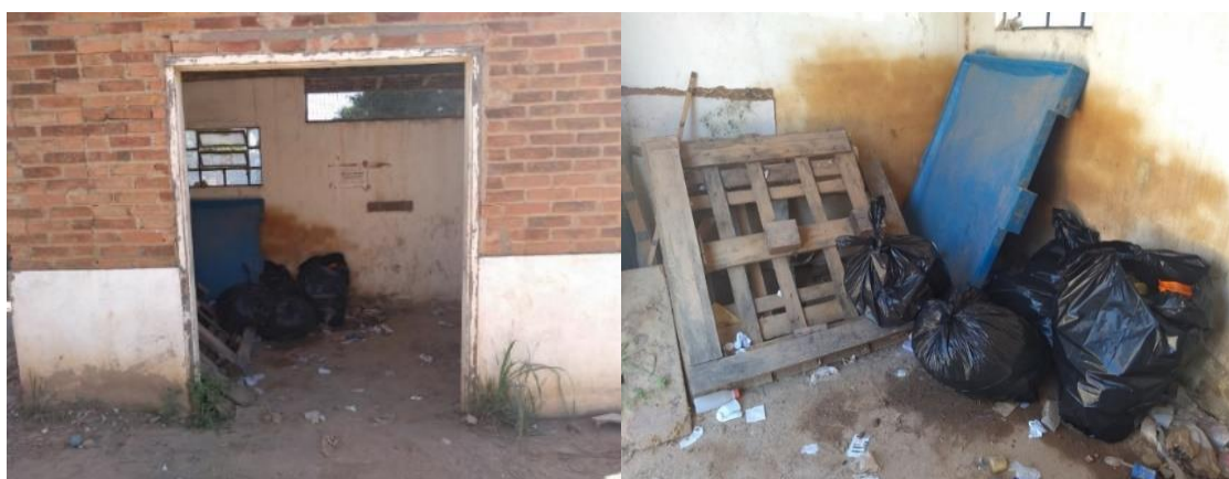
Figura 3 - a) depósito de lixo do Complexo Fepasa; b) interior do depósito de lixo.
