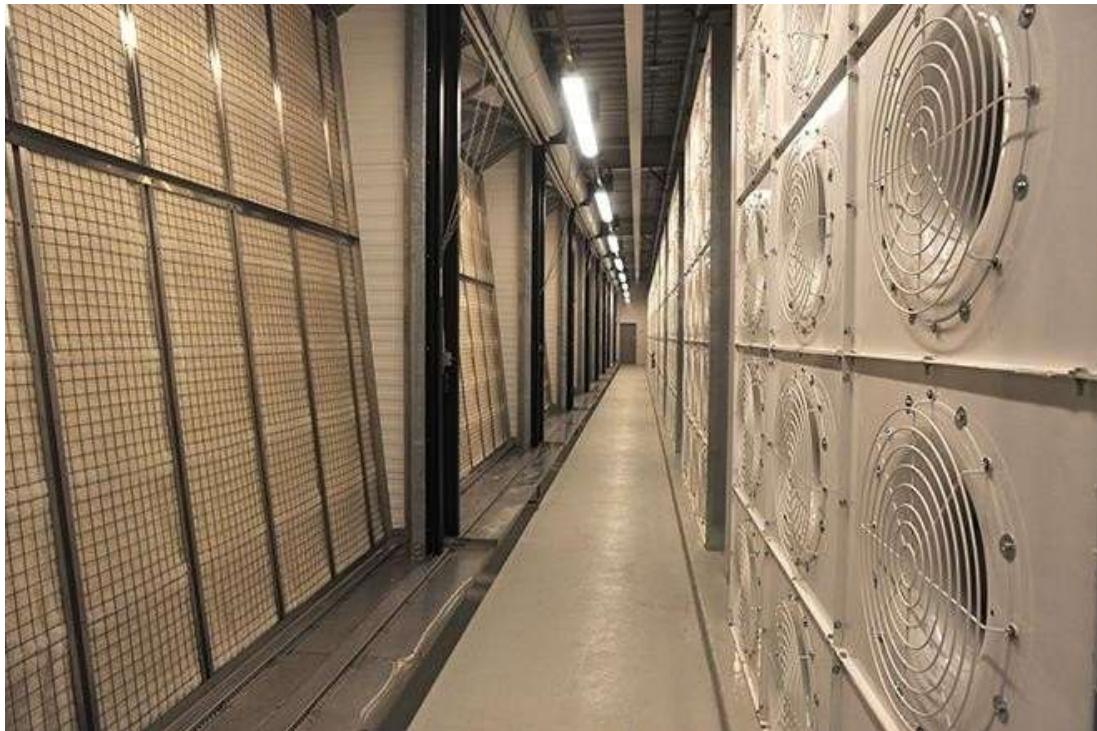
Figura 3 – Sistema de resfriamento do data center em Prineville
