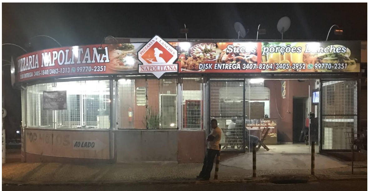
Figura 6 - Fachada parcialmente reformada
