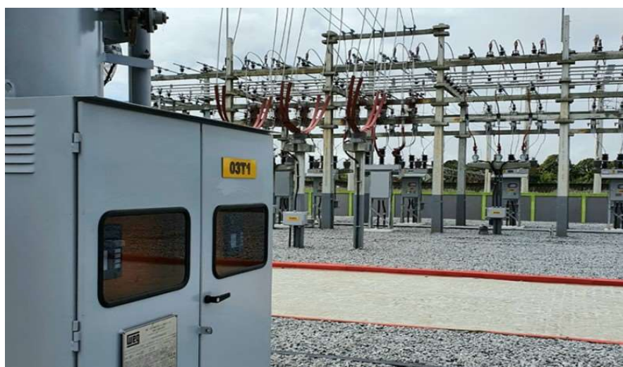
Figura 2 - Subestação seccionadora
