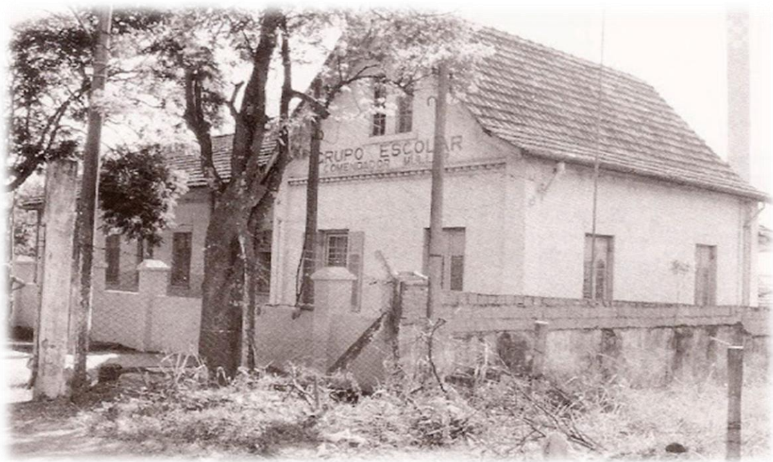
Figura 10 – Grupo Escolar Comendador Müller Construído em 1921, Foto de 1995
