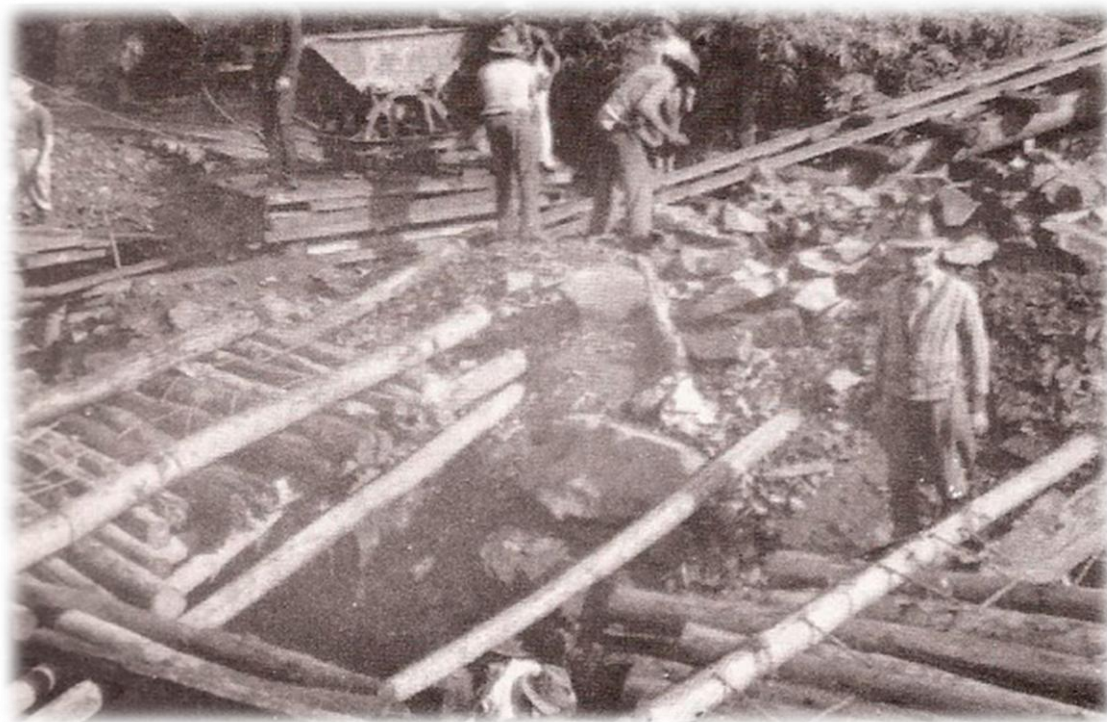
Figura 6 – Início da Barragem da Construção da Usina de Carioba
