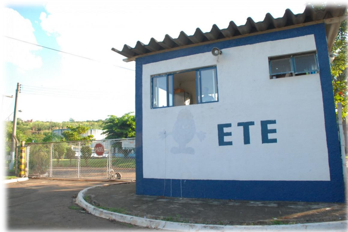
Figura 25 - Estação de Tratamento de Esgoto
