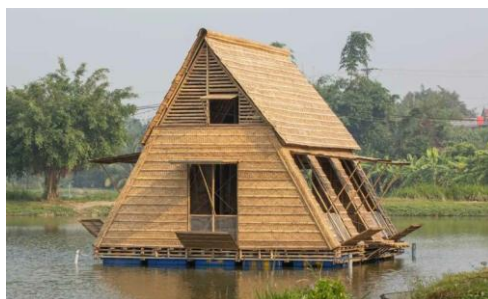
IMAGEM 5 — HABITAÇÃO RESISTENTES A INUNDAÇÕES NO VIETNÃ;
