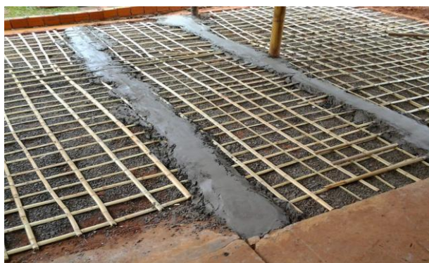
IMAGEM 7 — BAMBU SENDO UTILIZADO NA ARMAÇÃO RADIER
