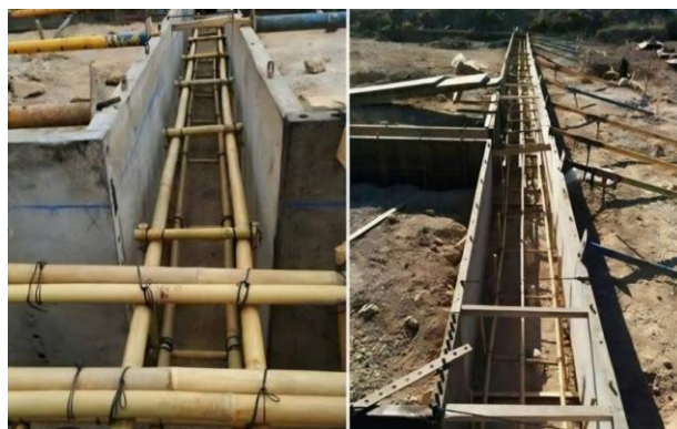
IMAGEM 6 — BAMBU SENDO UTILIZADO EM VIGA BALDRAME
