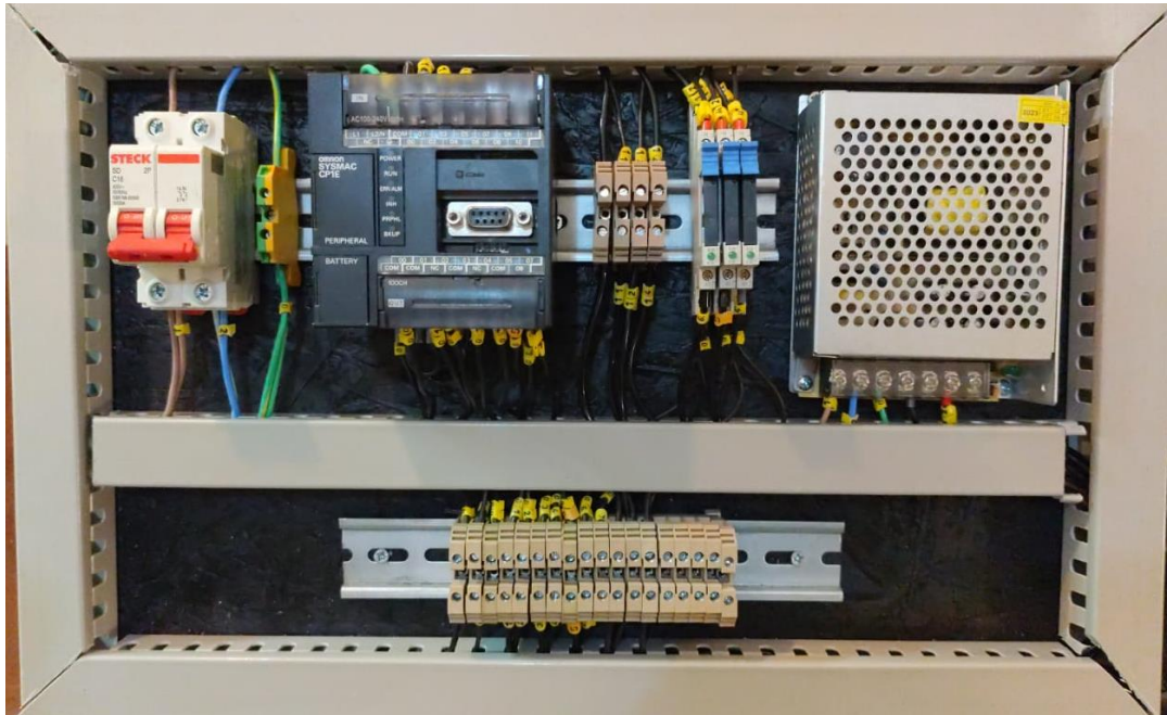
Figura 7 – Montagem do painel elétrico
