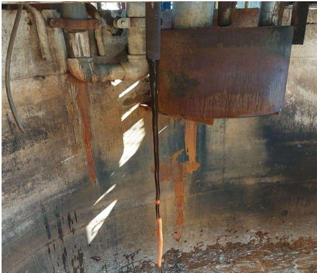
Figura 7 - Adição de mosto. Fonte: Figura do autor.
