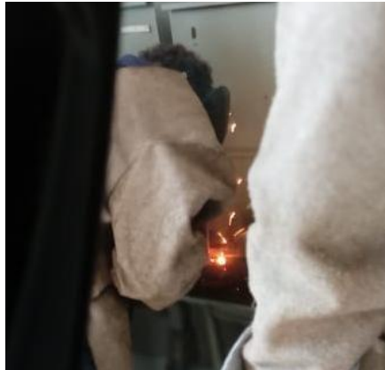
Figura 23: Processo de soldagem da base
