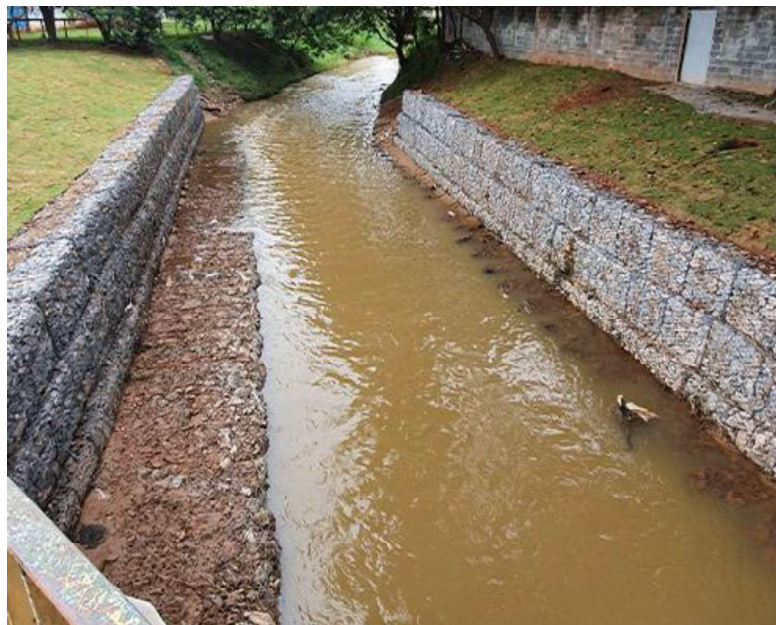
Figura 37-Córrego com muro gabião https://sotin.com.br/services/gabiao-tipo-caixa-zn-alpvc/
