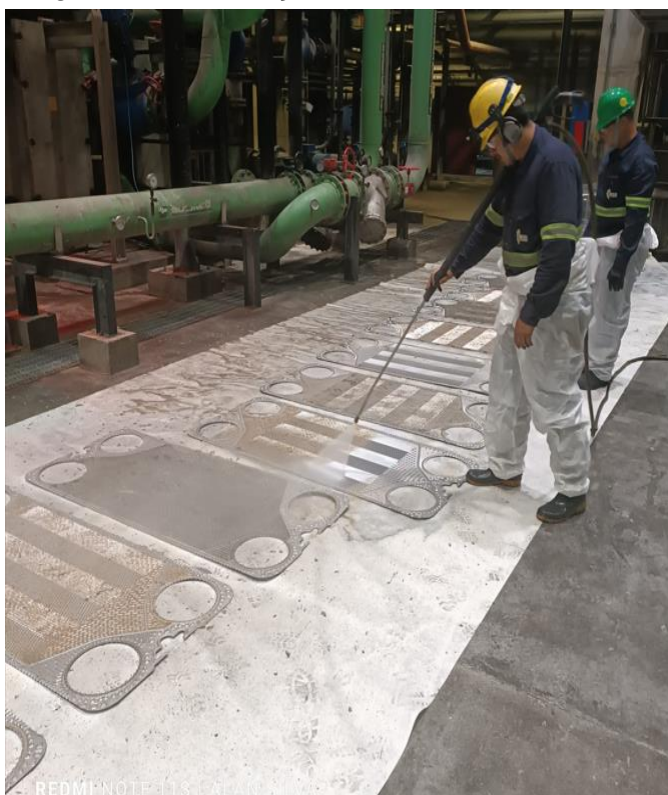
Figura 7: Manutenção nos trocadores de calor
