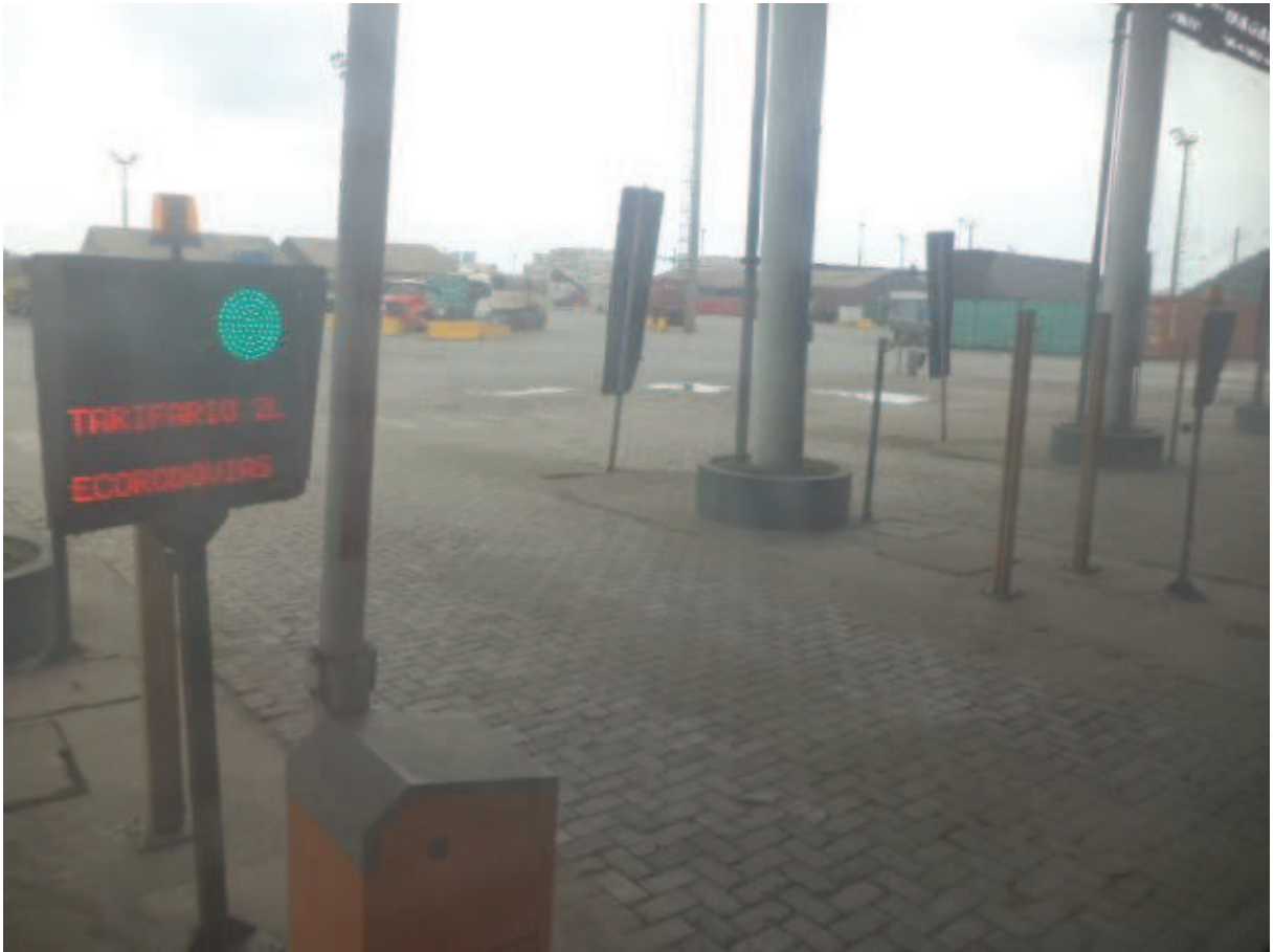
Figura 15: Abertura de cancela e indicação do bolsão para estacionamento
