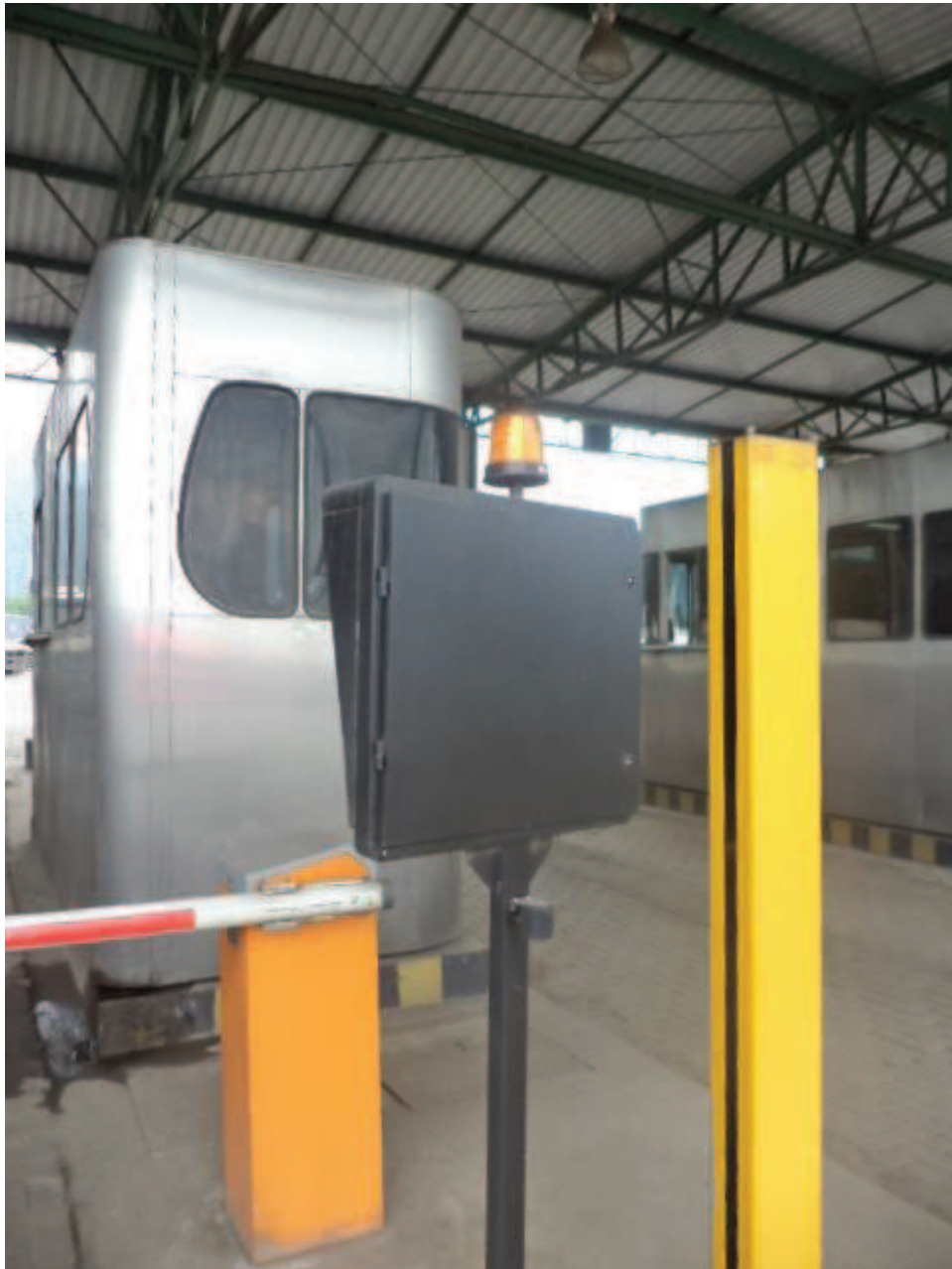
Figura 16: Cancela bloqueando o acesso do veículo no pátio regulador
