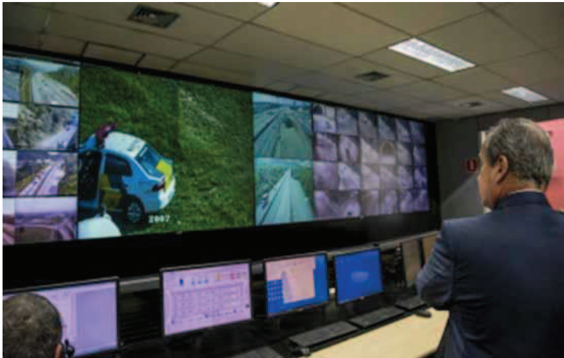
Figura 6: Modelo de Centro de Controle Operacional (CCO).
