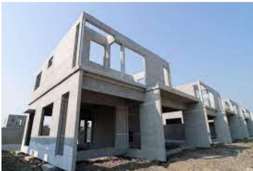
FIGURA 3 - CONCRETO PRÉ MOLDADO
