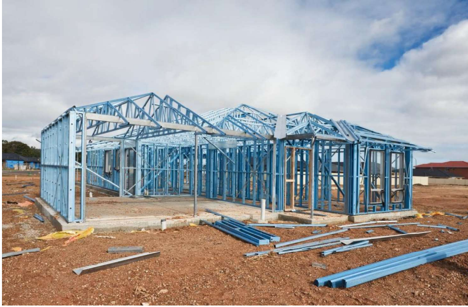
FIGURA 5 - ESTRUTURA EM STEEL FRAME
