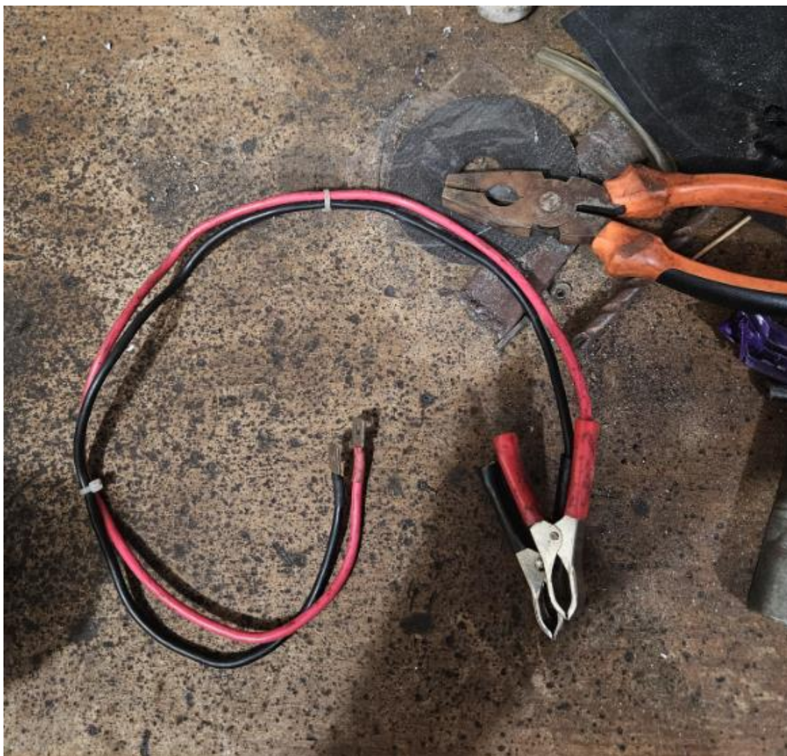
Figura 20 - Preparação do cabo condutor
