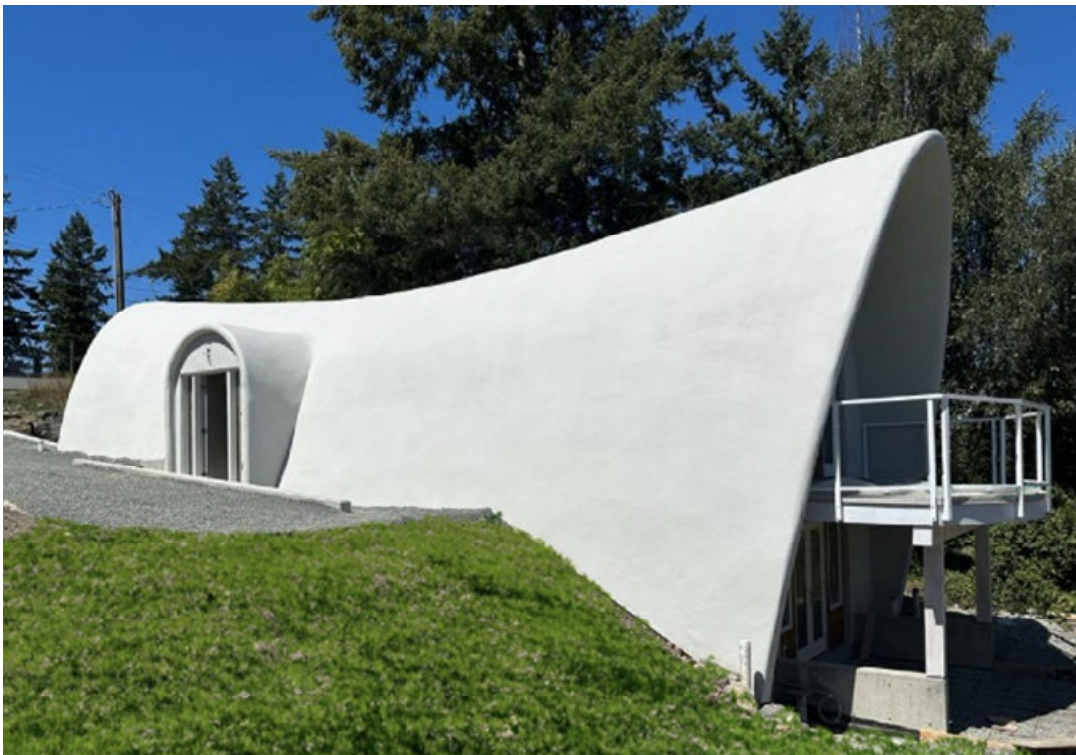
Figura 21: sistema E do modo construtivo da técnica Binishell
