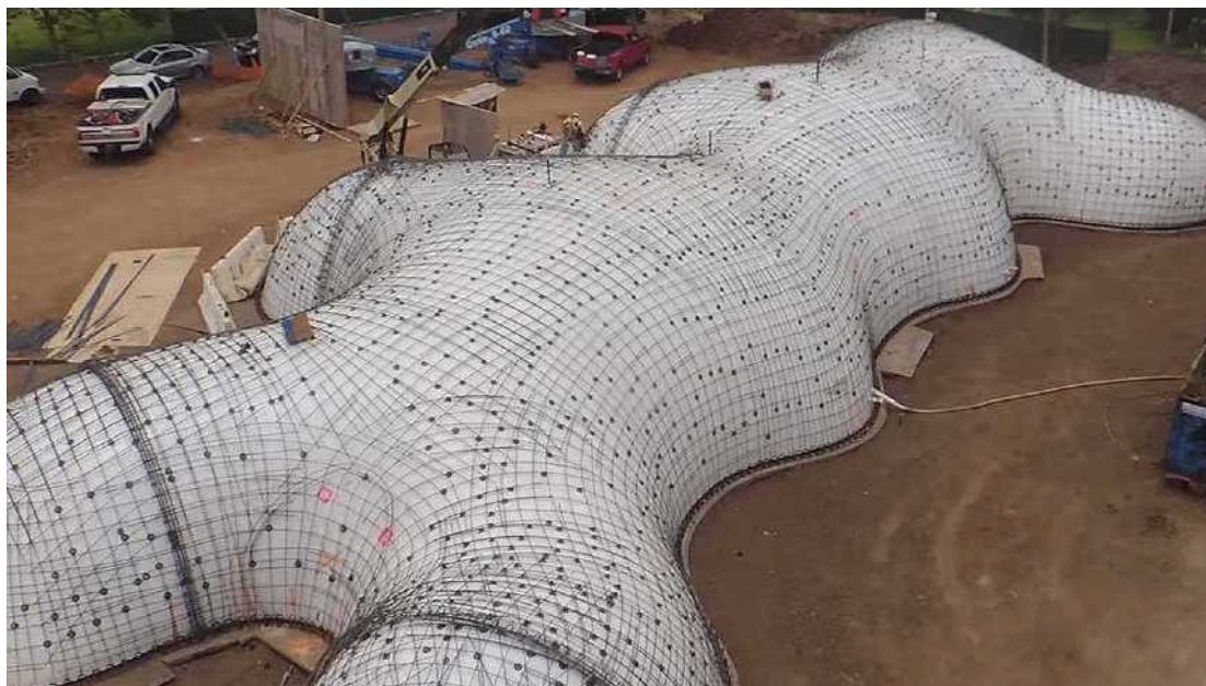
Figura 1: construção da Binishell
