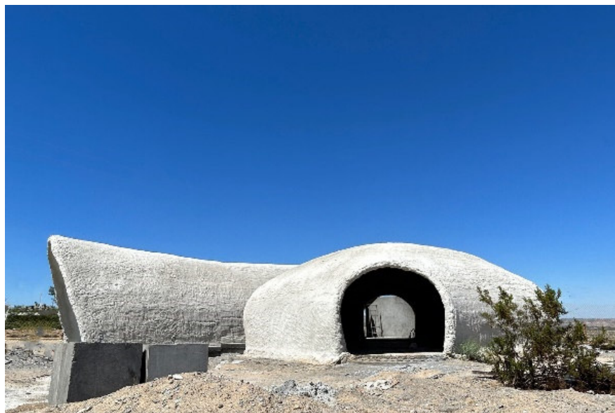
Figura 27: sistema E do modo construtivo da técnica Binishell
