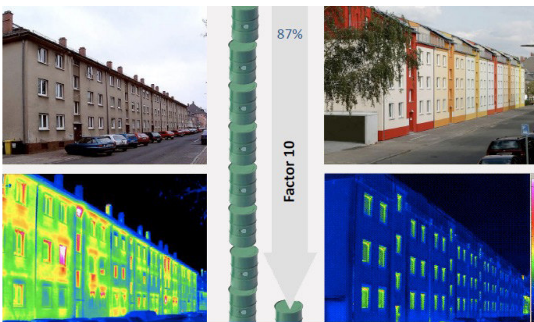
Figura 2: diferença no consumo de energia quando a ponte térmica é eliminada
