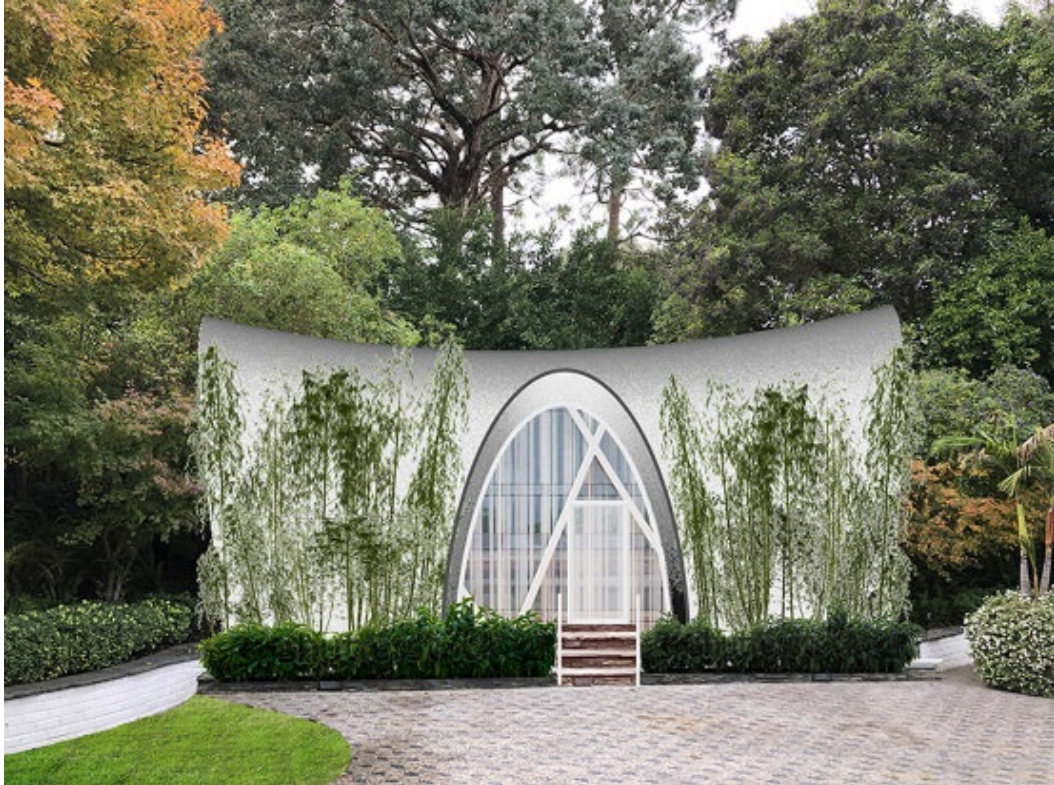
Figura 24: sistema E do modo construtivo da técnica Binishell
