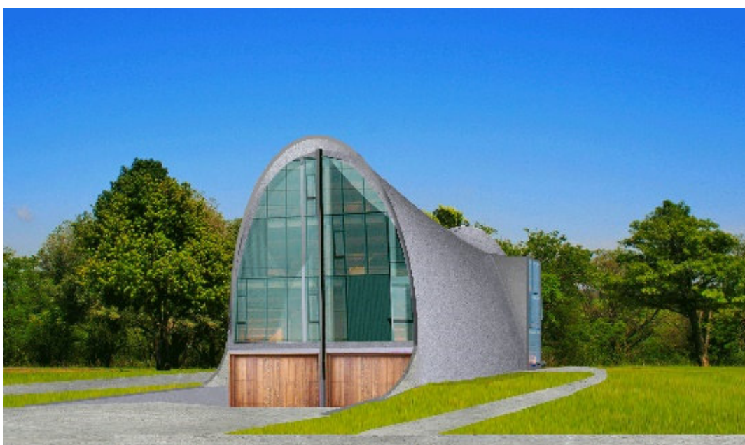
Figura 16: sistema D do modo construtivo da técnica Binishell
