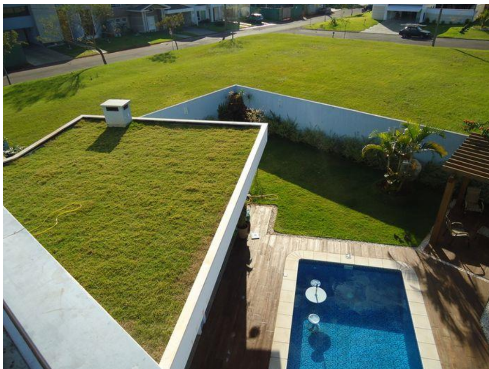
Figura 11 — Telhado verde extensivo
