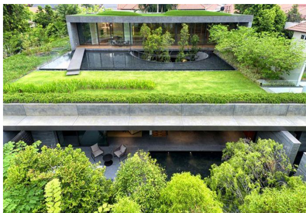
Figura 13 — Telhado verde semi intensivo
