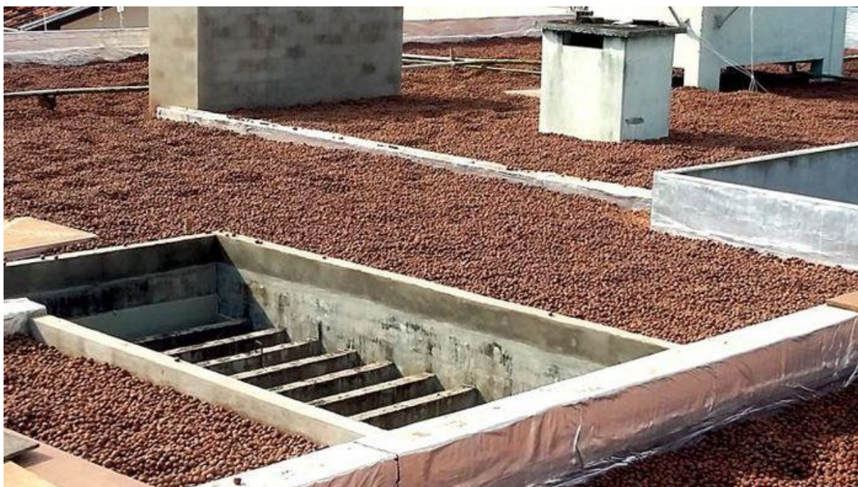
Figura 9 — Sistema de drenagem argila expandida
