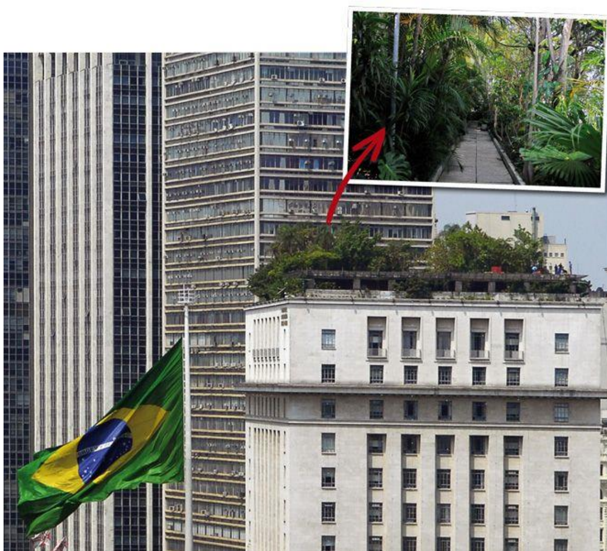
Figura 19 — Telhados verdes em são paulo
