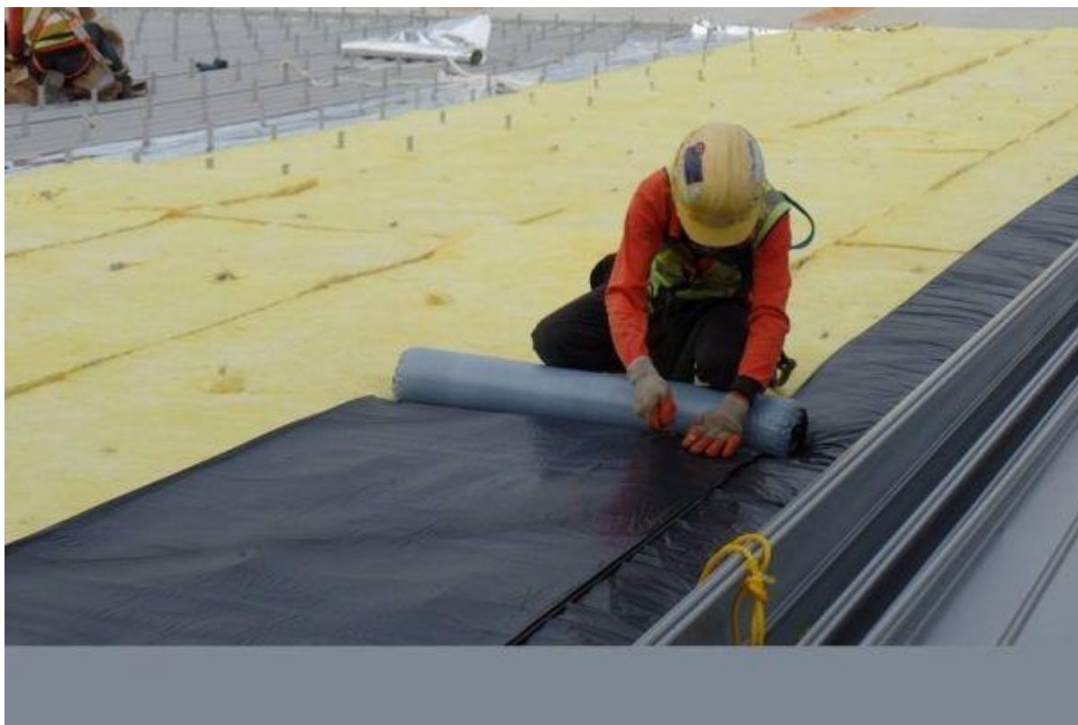
Figura 7 — Membrana impermeabilizante na construção
