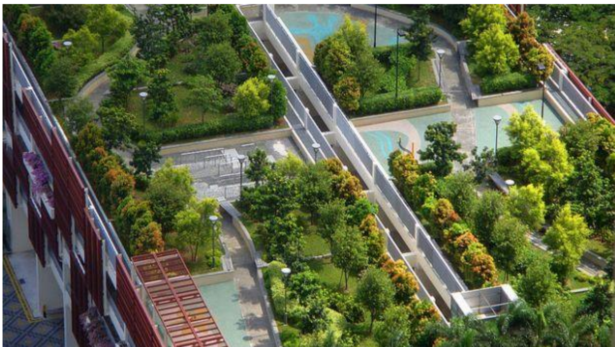
Figura 12 — Telhado verde intensivo
