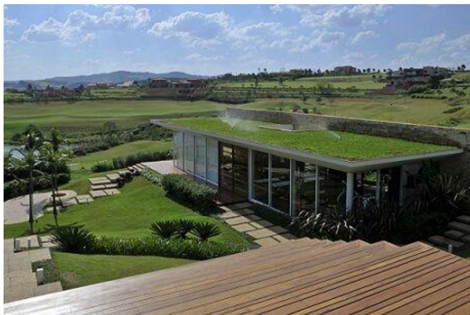
Figura 4 — Telhado verde em steel frame
