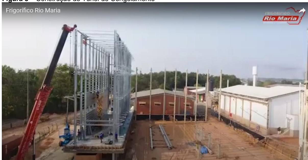
Figura 3 – Construção de Túnel de Congelamento
