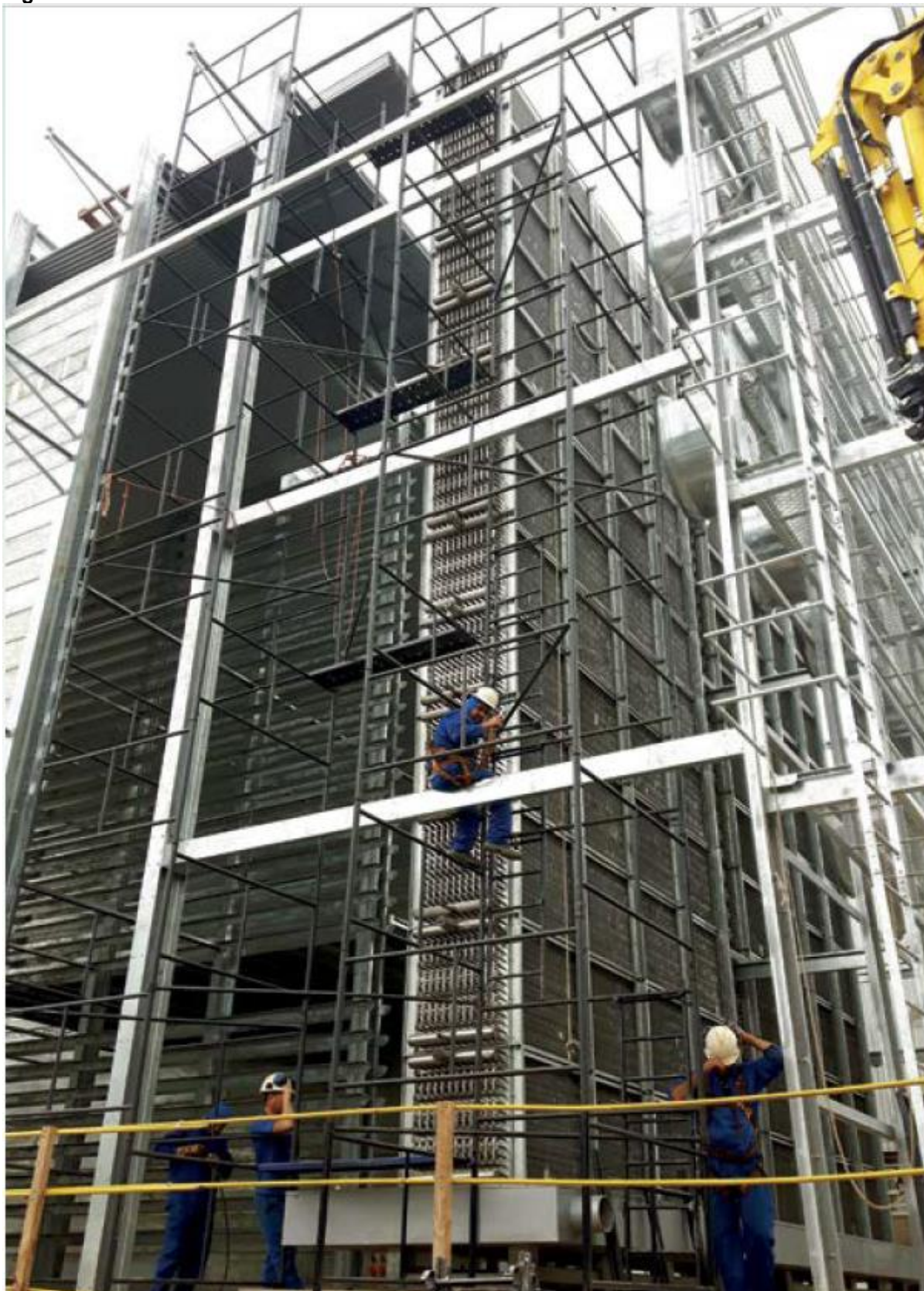
Figura 40 – Estrutura Metálica do Túnel Prédio
