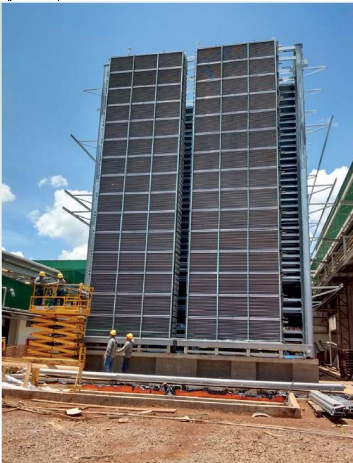
Figura 39 – Evaporador do Túnel “Prédio”
