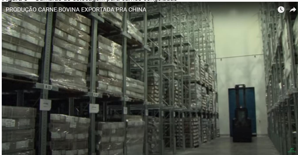
Figura 8 – Câmaras de estocagem para carnes congeladas
