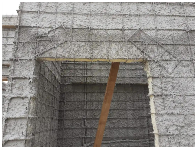
Figura 10: Painel com primeira camada de argamassa projetada
