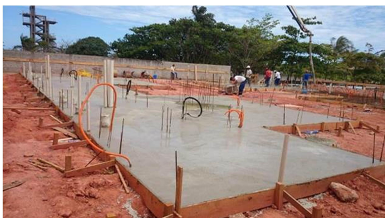
Figura 5: Fundação do tipo rasa - Radier
