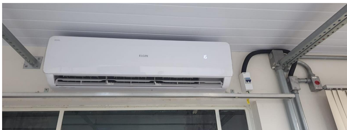
Figura 6 – Instalação do ar-condicionado em sala de aula FONTE: Arquivo Pessoal
