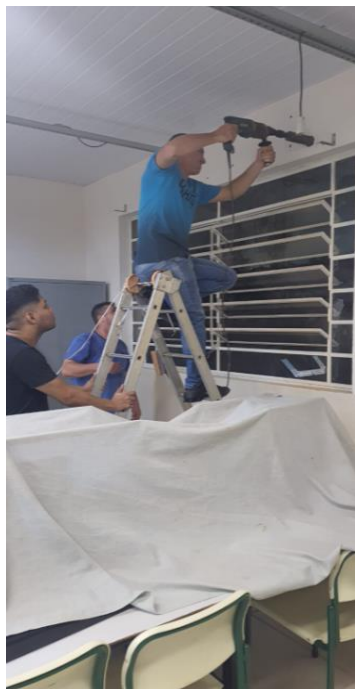
Figura 3 - Furação das paredes
