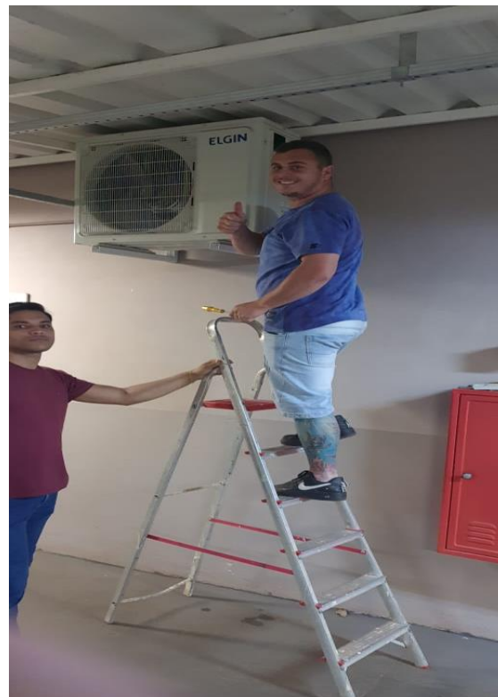
Figura 8 – Finalização das instalações
