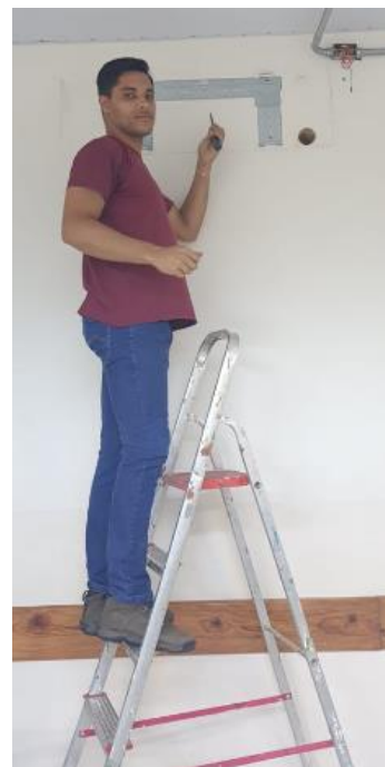
Figura 5 – Fixação dos suportes
