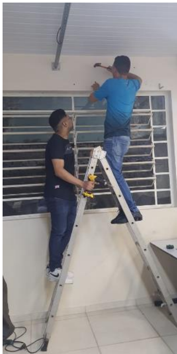
Figura 4 – Marcação dos furos para o suporte
