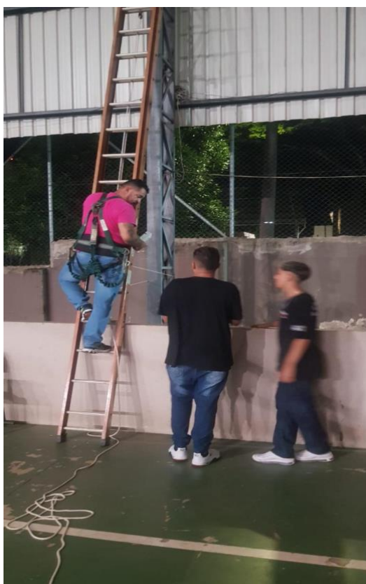
Figura 5: Manutenções de refletores da quadra poliesportiva.
